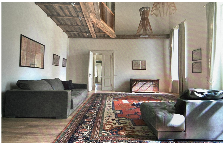
Privātmājas pārbūve - Pārcelta marga un “tiltiņš” no otreizēji izmantota koka. Atpaļķis sazāģēts dēļos.
