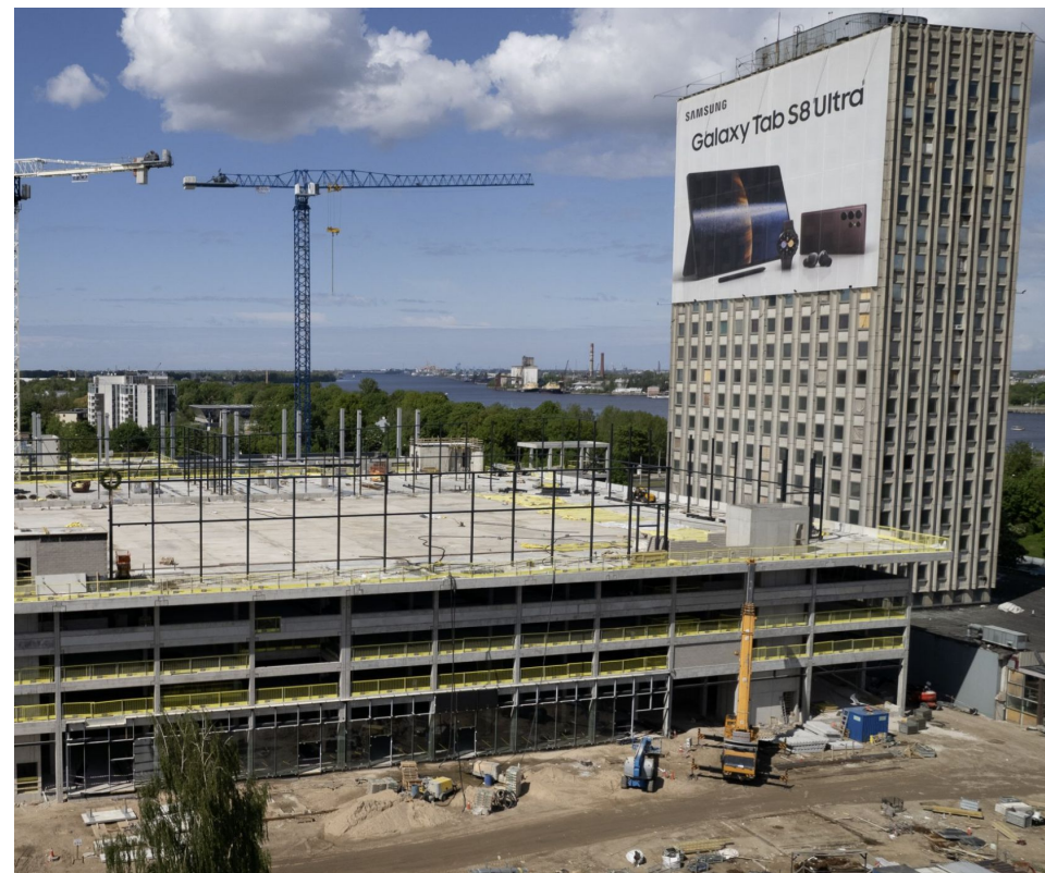
Preses nams- Demontētā betona šķembas ir iejaucamas jaunā betonā. Pieļaujamā proporcija - ap 15% no kopējās masas. Arhitekti - Arhis
